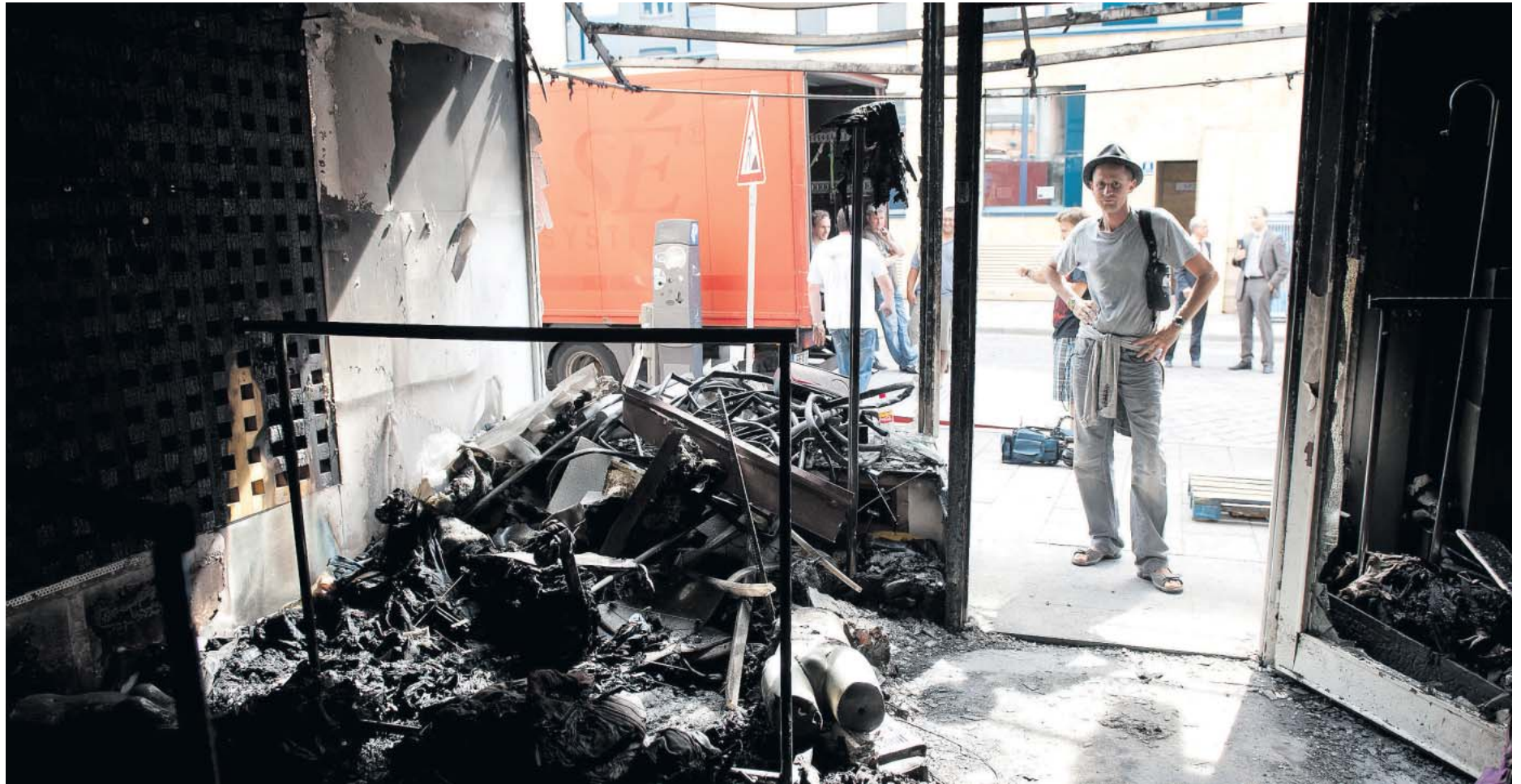
Spätfolgen des Kriegs: Ausgebranntes Bekleidungsgeschäft in München nach der kontrollierten Sprengung einer Weltkriegsbombe im Jahr 2012
